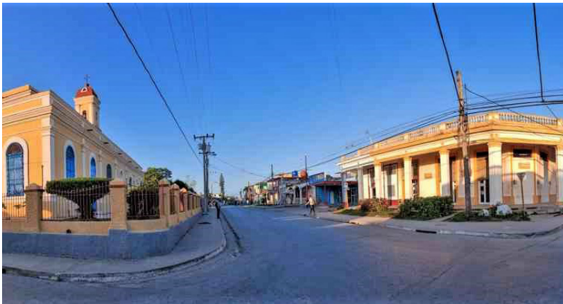
Esquina de la avenida 51 y la calle 62
