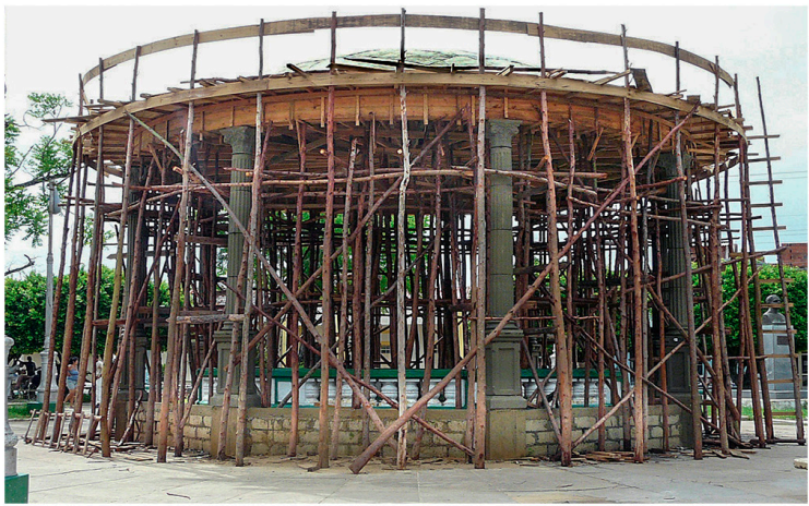
Construcción glorieta techada, 2010
