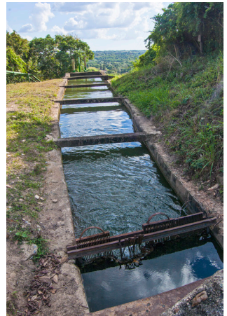
Canales conducción del agua
