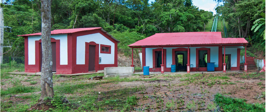
Hidroeléctrica El Salto, en Pilotos, construida en 1912
