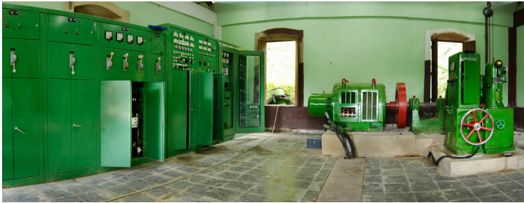
Sala de máquinas actual
